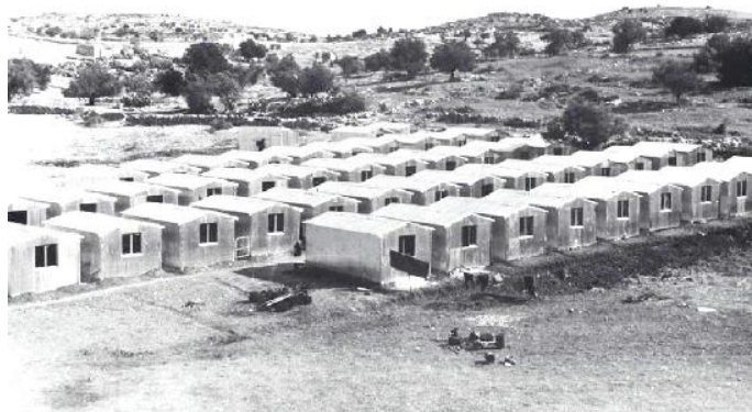
איור 1 - מבנים במעברת בתלפיות
