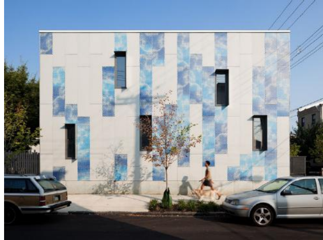
איור 18 100K House
