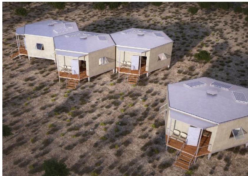
איור 30 - Hex House בשטח
