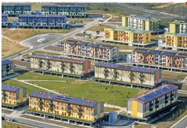
איור 34 - C.A.S.E. Project בשטח
